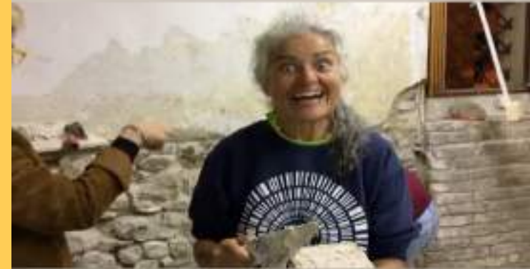
ristrutturazione della sede da parte dei volontari
