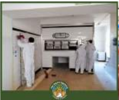
ristrutturazione del vecchio forno
